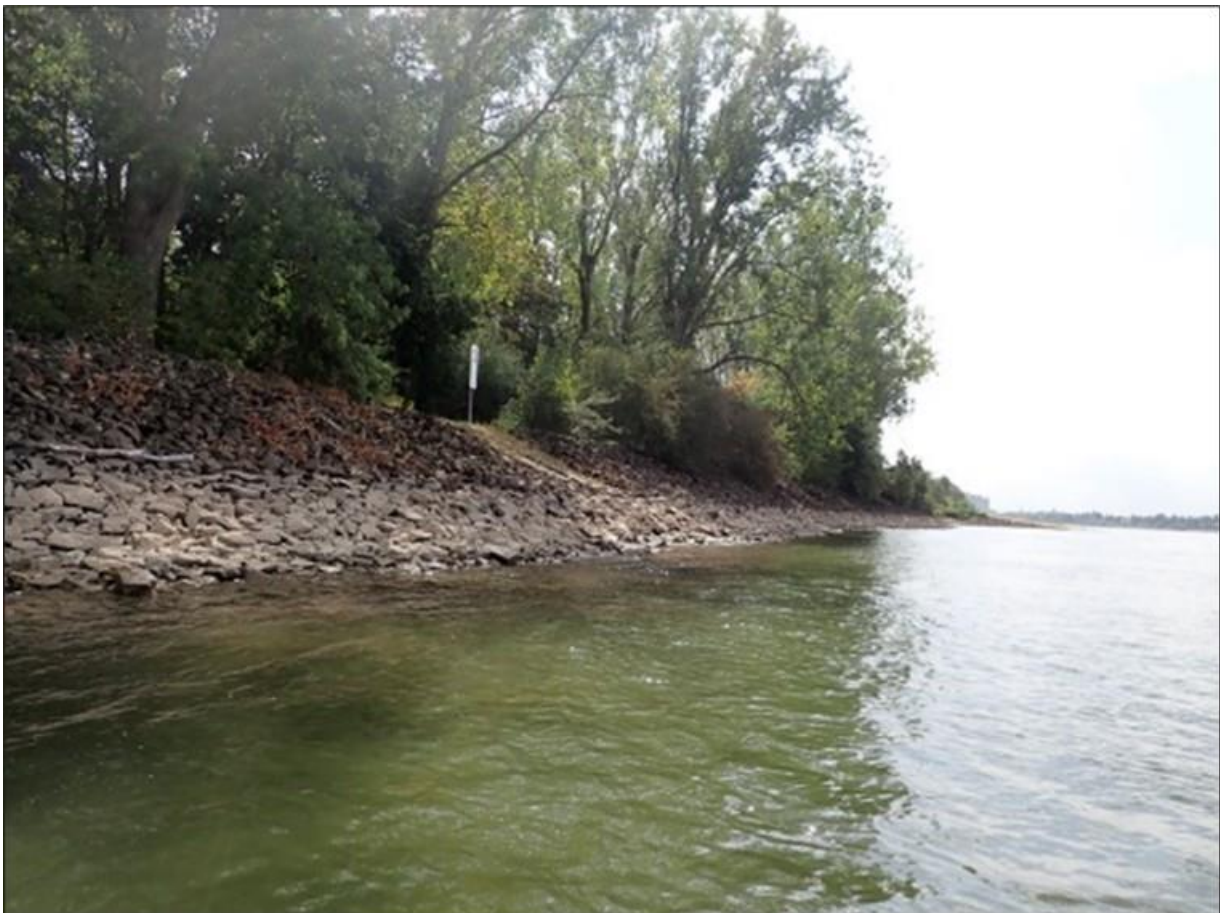
Abbildung 2-4: Rhein, oberhalb Weschnitzmündung (Foto 2021).
