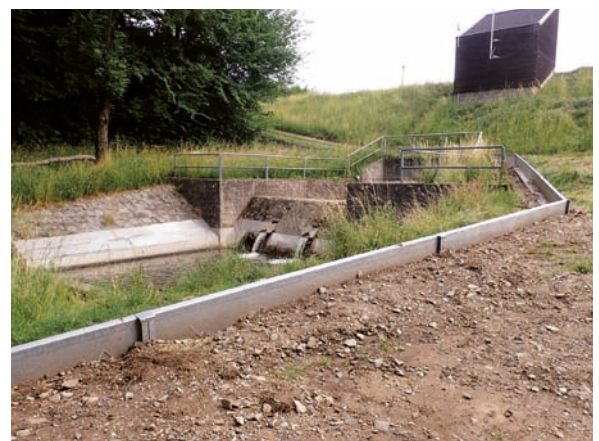
Beispiel einer Krepssperre im Landkreis Bergstraße
