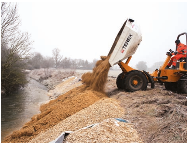
Einbringung von Kies (Foto links) und Zustand nach einigen Monaten (Foto rechts)
