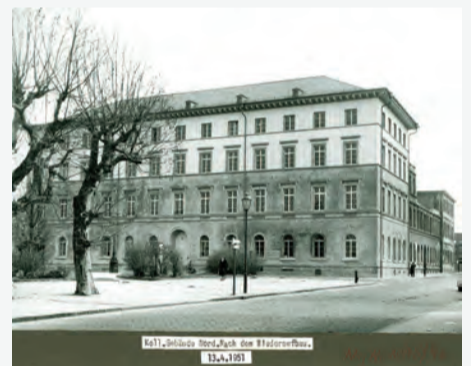
Blick auf das wiederaufgebaute Haus von Norden, 1951 Hessisches Staatsarchiv Darmstadt
