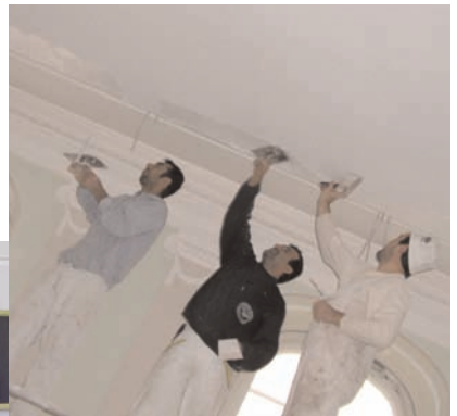
Bild 63 - Umbau Sitzungssaal Süd, seit 2012 Ludwig Bergsträsser-Saal
