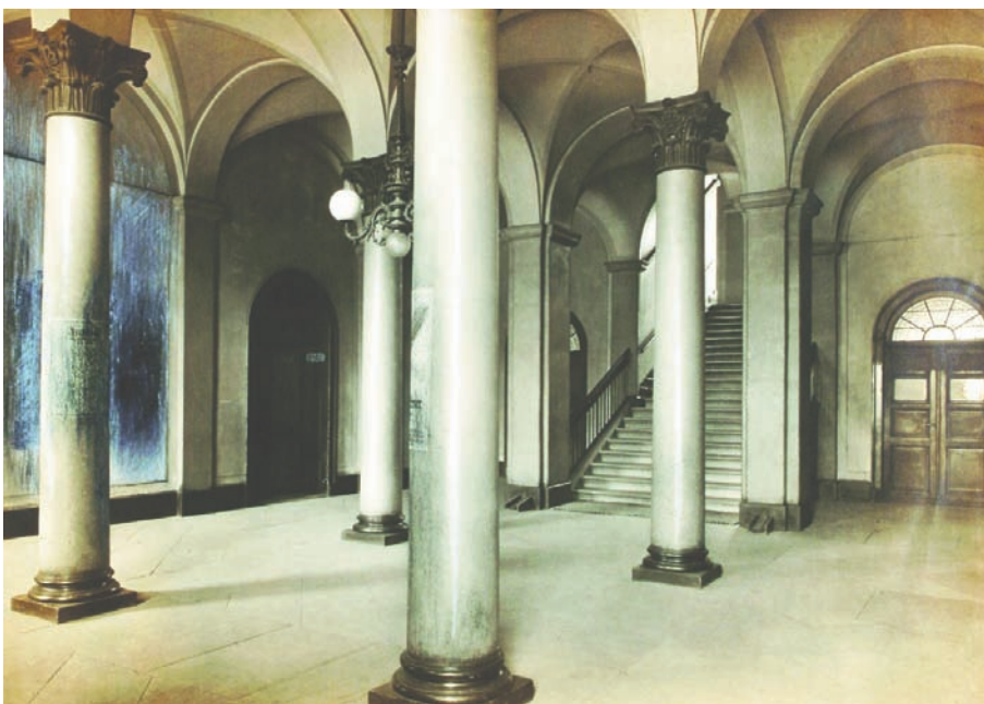
Bild 11 - Foyer „Neues Kanzleigebäude“ um 1930
