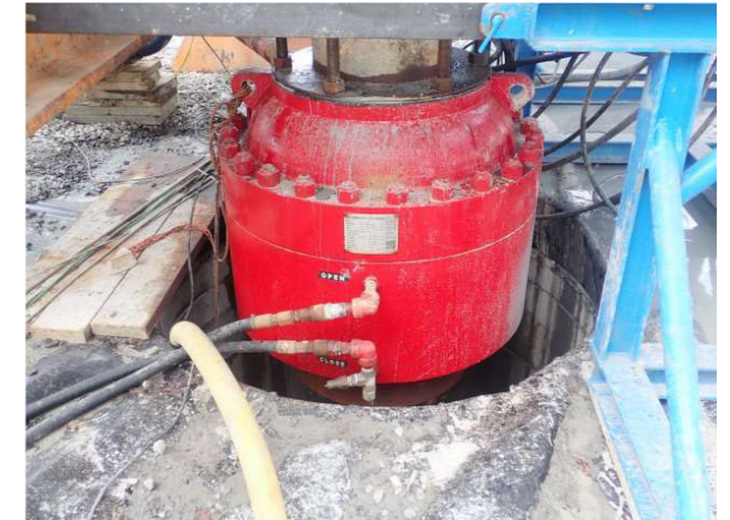
Diverter auf Bohrloch (© RP Darmstadt)
